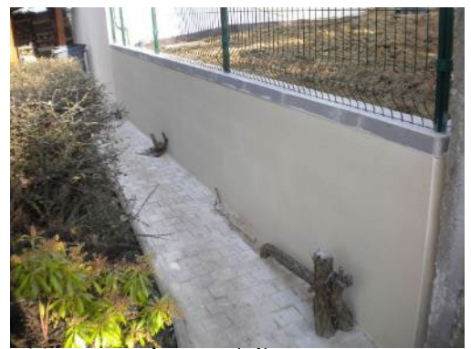
Mur parpaing enduit
